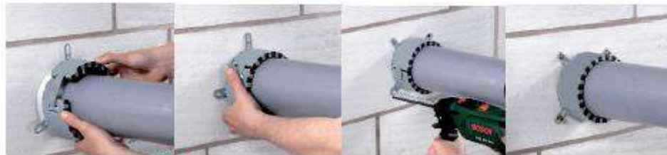
Монтажа на противпожарна манжетна
